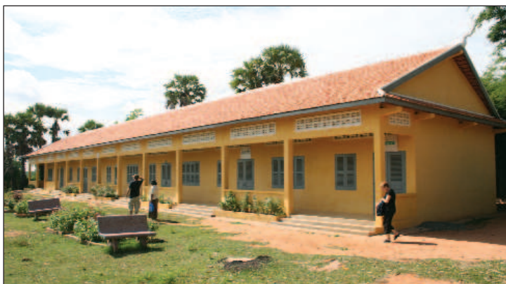
Ecole Poy Svay, commune de Rohal, forage à 80 m
